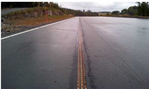
Figur 2: Konduktiv laddning via skena i vägbanan. (Trafikverket 2019)
